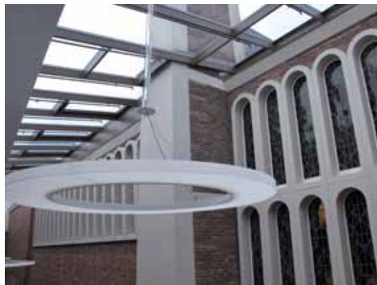
Alt und neu verbunden: Ein Glasdach verbindet Magistrale und Kapelle
